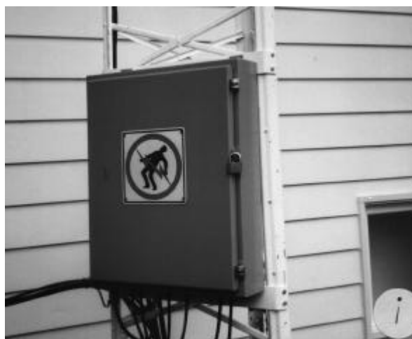
I: Vue d'ensemble du montage au pied de la tour
