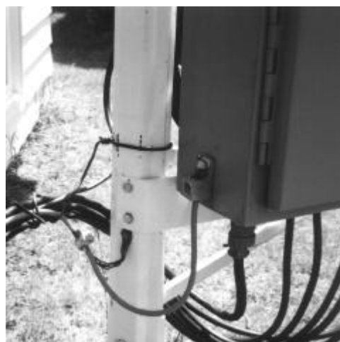
H: On remarque la mise à la terre de la B.J. Également une meilleure vue du câble de commande en dessous de la B.J.
