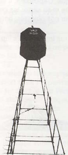
Vue de la répétitrice VA2RSP. Antenne: 210A4. Cabane octogonale en acier galvanisé de couleur orange internationale et éolienne.
