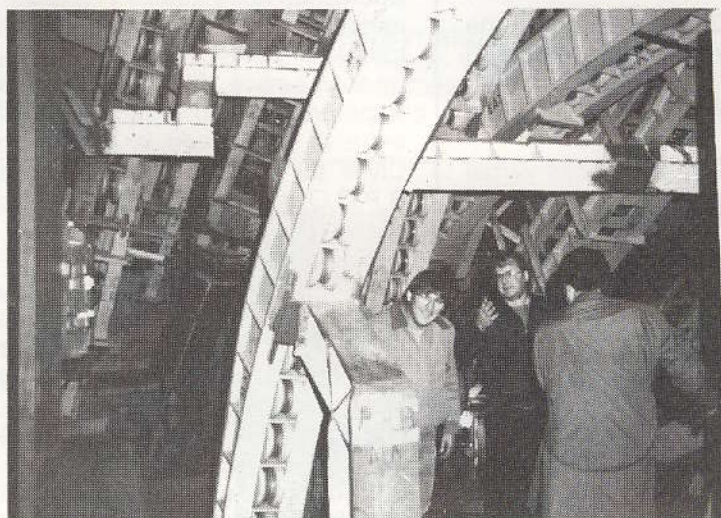
Visite de l'intérieur de la tour du mât du stade. Dans cette niche on voit, devant, un des rails soutenant les câbles de la toile. (Photo Jean-Pierre VE2AX). Voir article page suivante.
