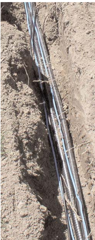
Les cables dans la tranchée vers les antennes.
