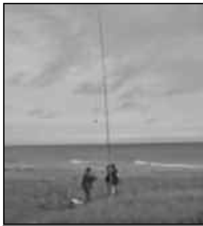
Rosaire VE2GHZ et Jacques VE2AZX, installant une antenne verticale 40 mètres de leur fabrication lors d'un voyage à l'île Miscou au Nouveau-Brunswick en 2005
