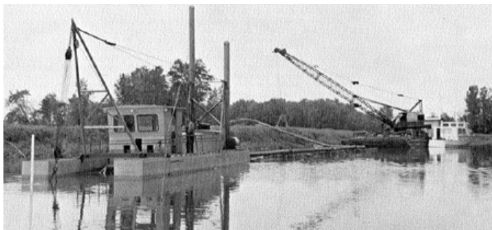
Équipement de dragage dans la Rivière du Loup à Louiseville
