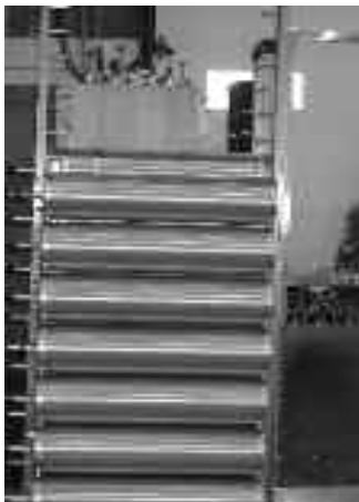
Groupe de duplexeurs montés en multicoupleurs
