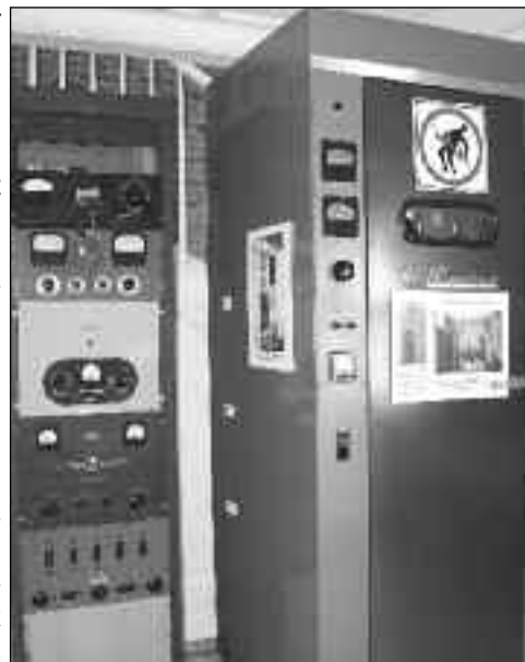
Transmetteur de 1000 watts de CJSO
